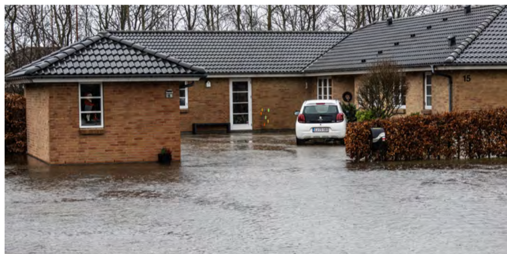
I nr. 15 var det også meget tæt på, at man fik vand ind i huset. Foto: Jim Hoff
