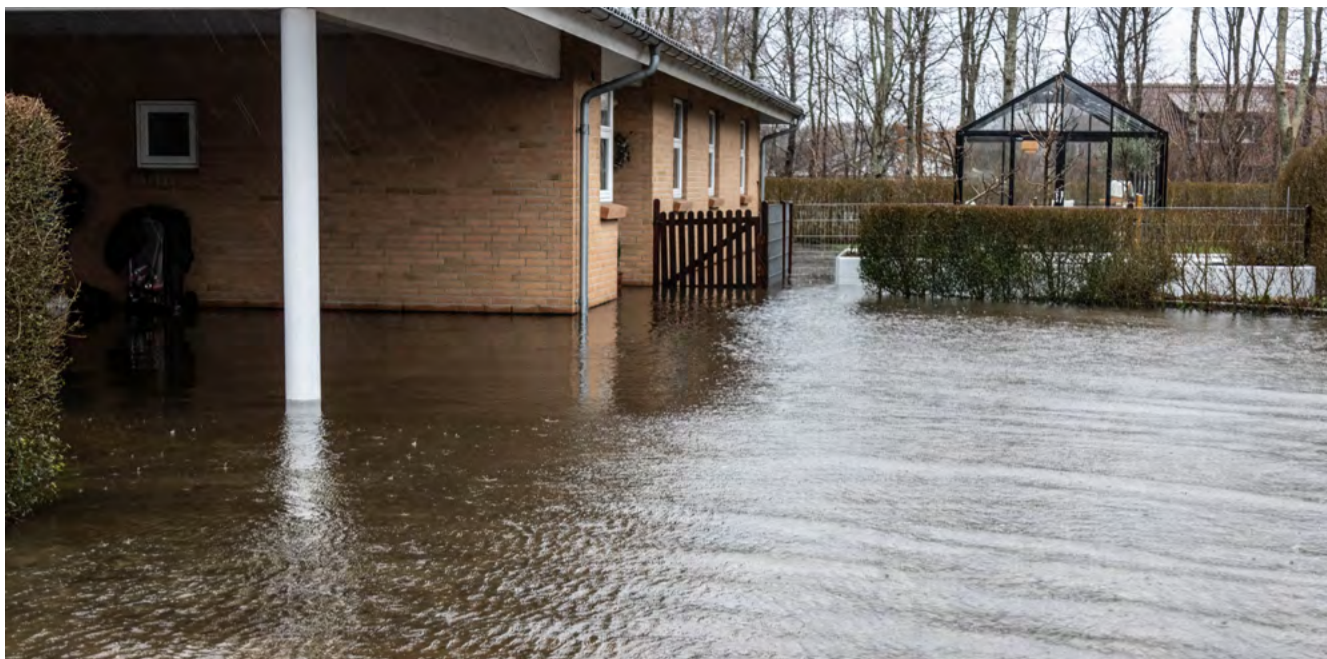
På Højvang nr. 11 var det blot 2 centimeter fra, at vandet skyllede ind i huset tirsdag i sidste uge – og det er et vedvarende problem, fordi regnvandet fra Anemonevej skylles ned mod især 3 huse på Højvang. Foto: Jim Hoff
