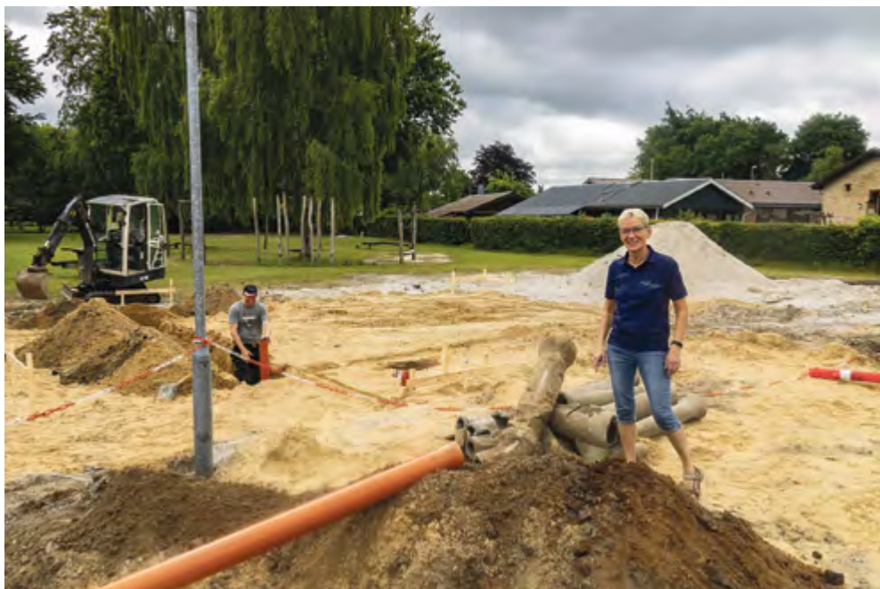
Her ser vi centerleder Lone Jørgensen ved den udgravning ved grunden bag ved svømmehallen, der med gode håndværkeres hjælp skal ende op med et saunahus på 96 m 2 . Foto: Jim Hoff
