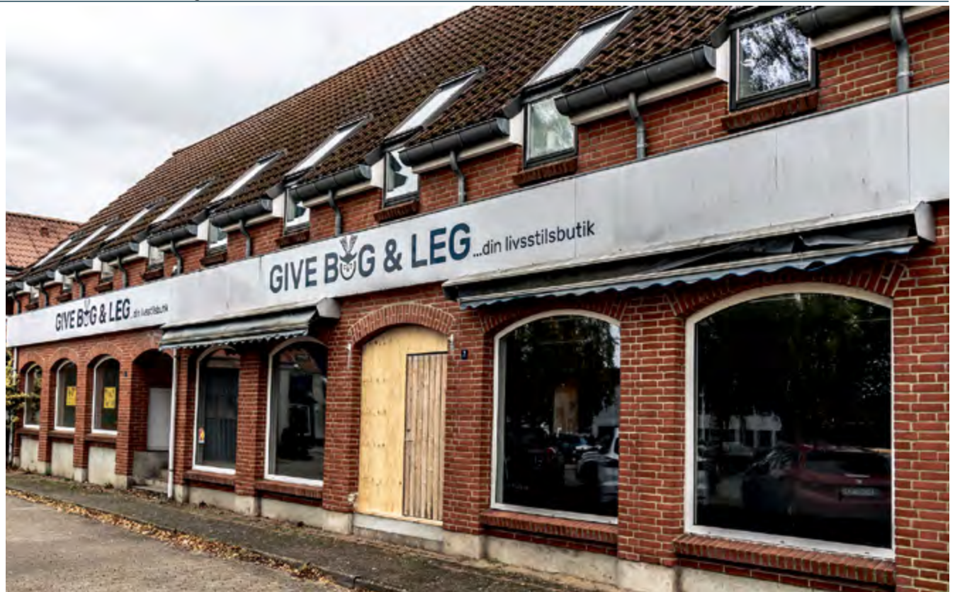
Foto: Her på bagsiden af bygningen, der tidligere har rummet byens boghandel, er der etableret to lokaler/enheder, og de er allerede lejet ud. Foto: Jim Hoff
