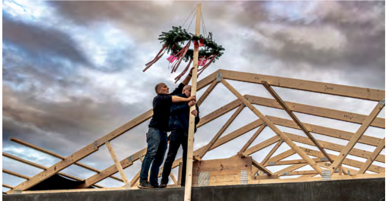
Tirsdag den 16. december blev der holdt rejsegilde på Hedegård Friskole, hvor man er i gang med at bygge 250 m², der skal rumme skolens nye 9. klasse samt 8. klasse. Her ser vi to friske gutter i gang med at hejse kransen. Foto: Jim Hoff
