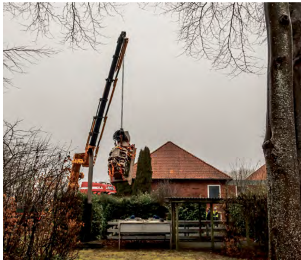
Foto: Generatoren blev anbragt på den store transportvogn i sikker stil, og nu er det virksomheden Nutrimin, der skal sørge for, at generatoren kommer sikkert til Ukraine. Foto: Jim Hoff
