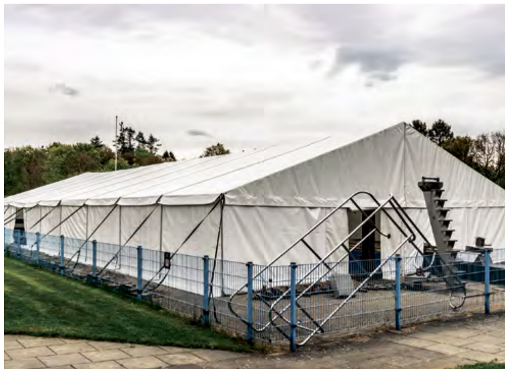
Det store bassin i friluftsbadet i Give har været overdækket af dette 'festtelt' i cirka 3 uger under renoveringen. Foto: Jim Hoff
