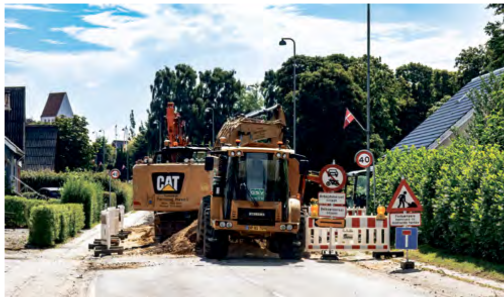
Foto: Lige nu er en del af Bygade i Vonge gravet op grundet kloakarbejde -og det burde i følge læserbrevsskribenten være en kærkommen lejlighed til at man får etableret fortov med kantsten. Men det sker desværre ikke! Foto: Jim Hoff
