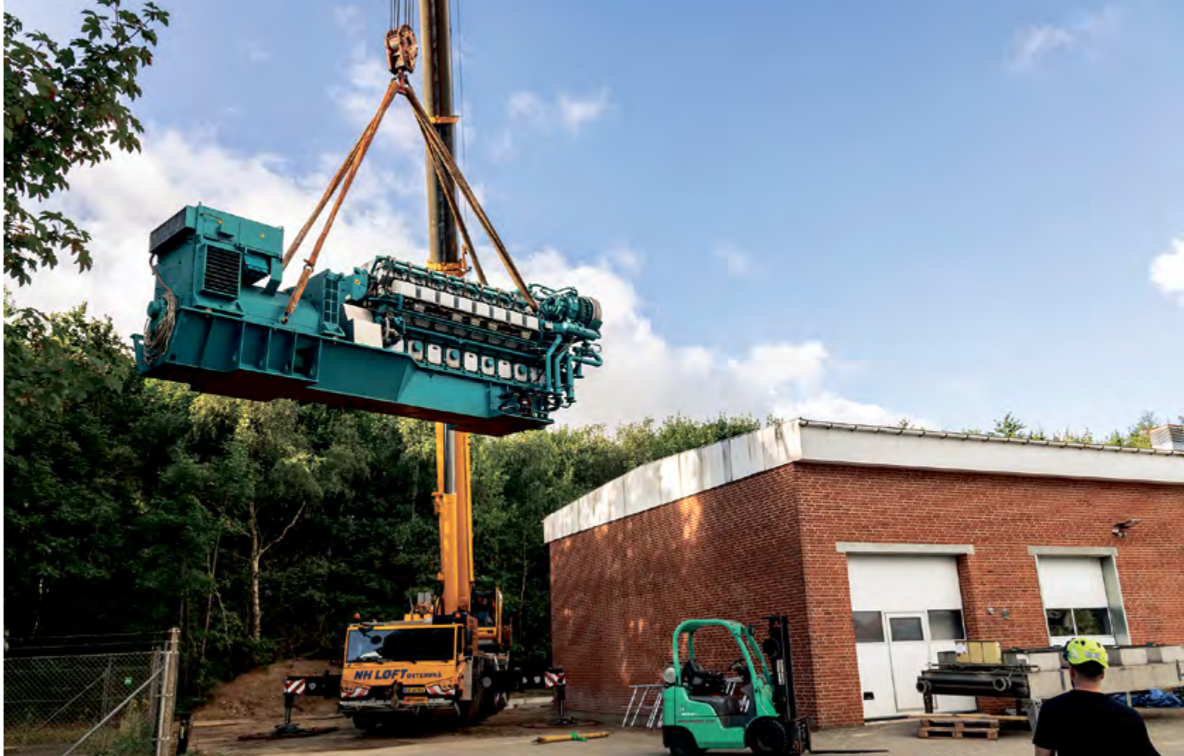
Foto: Den cirka 40 tons tunge gasmotor fra fjernvarmen i Give blev torsdag morgen løftet ud af hallen og anbragt på en lastbil for at blive transporteret til Tyrkiet. Foto: Jim Hoff
