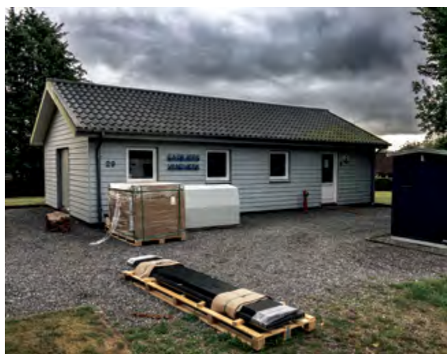
Foto: Give Vandværk får i disse dage påmonteret solceller på taget af bygningen på Buen 29. Derudover installeres der også en 30 KW batteripakke inde i bygningen. Foto: Jim Hoff
